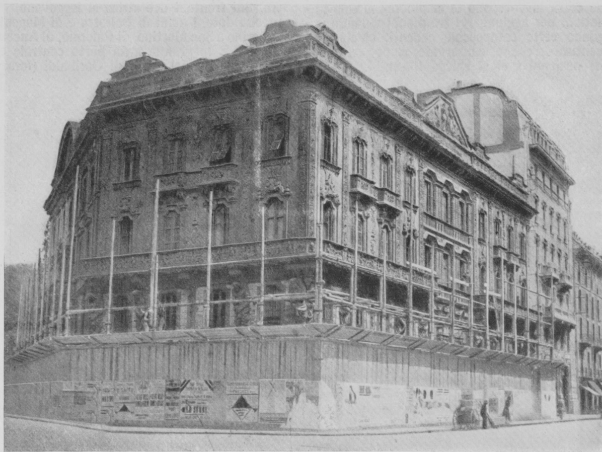
MILANO — LA CASA ROSSA FASCIATA PER LA DEMOLIZIONE.
